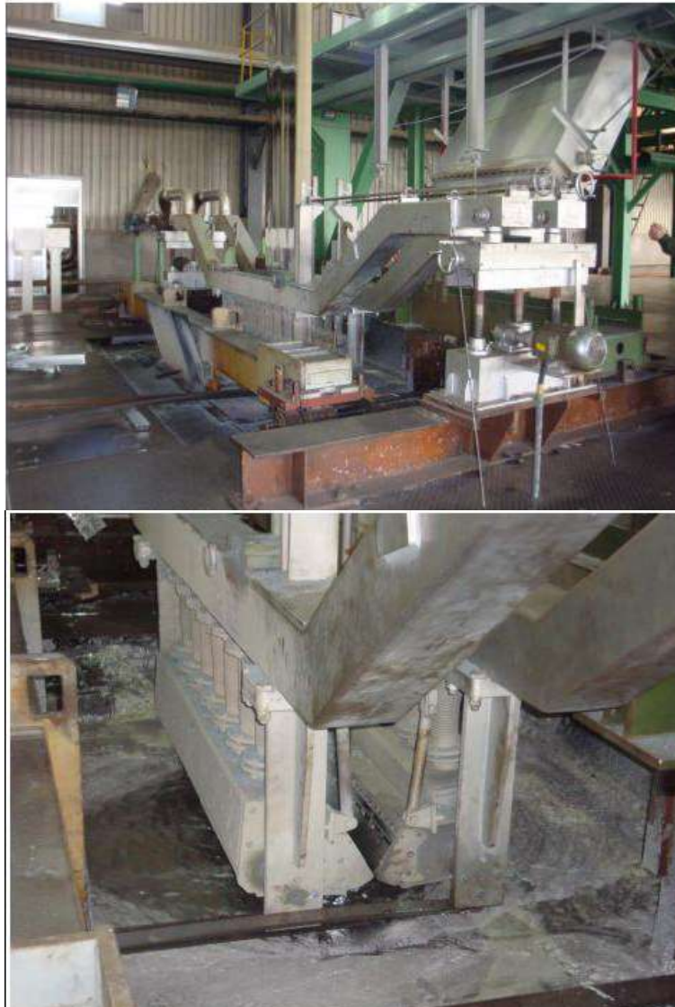
图3.7-1 国内连续热度锌机组锌锅工段实景
